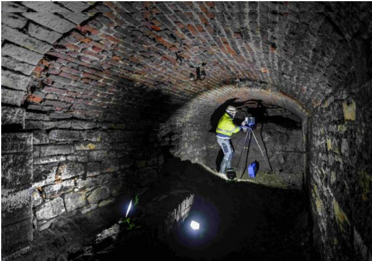
Erkundung eines ehem. Herdebahn-Tunnels der Henrichshütte in Hattingen mittels 3D-Scanning, 2016
