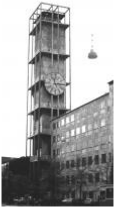
Abbildung 34: Uhr- und Glockenturm Rathaus Århus, Dänemark, bekleidetes Stahlbetonskelett und massiver Kern mit 60 m Bauhöhe
